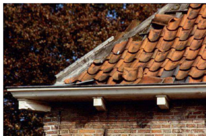
Herstel lood en pannen conform bestaande toestand: vergunningvrij
