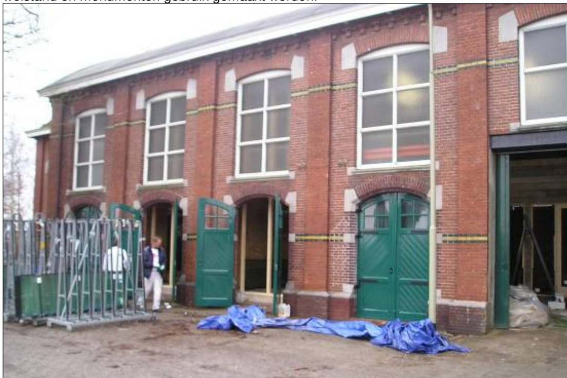
voorbeeld van vergunningverlening: herplaatsing van deuren in de Turfcentrale (rijksmonument)
