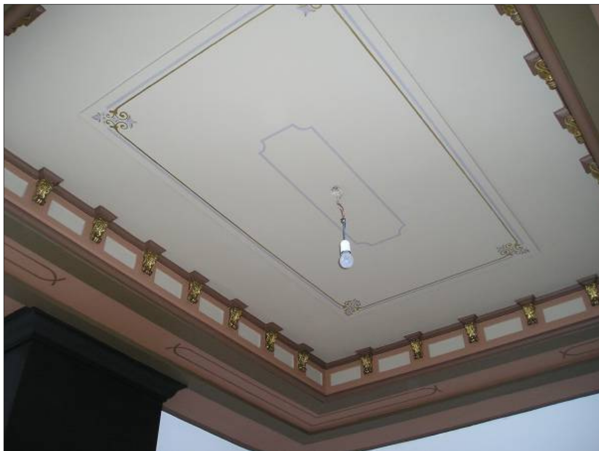
in oude luister hersteld plafond in een rijksmonument
